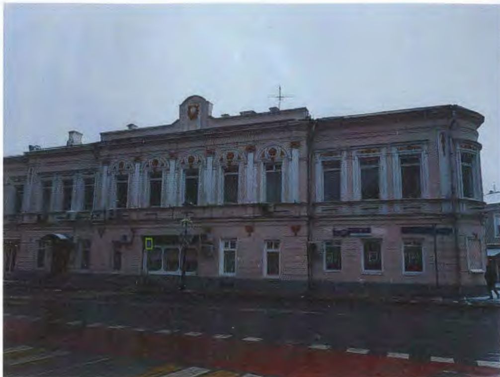
Фото 1. Общий вид здания по оси «А»
