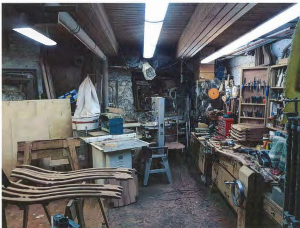
Фото 2. Общий вид помещений подвала в осях «7-10/Г-Ж»
