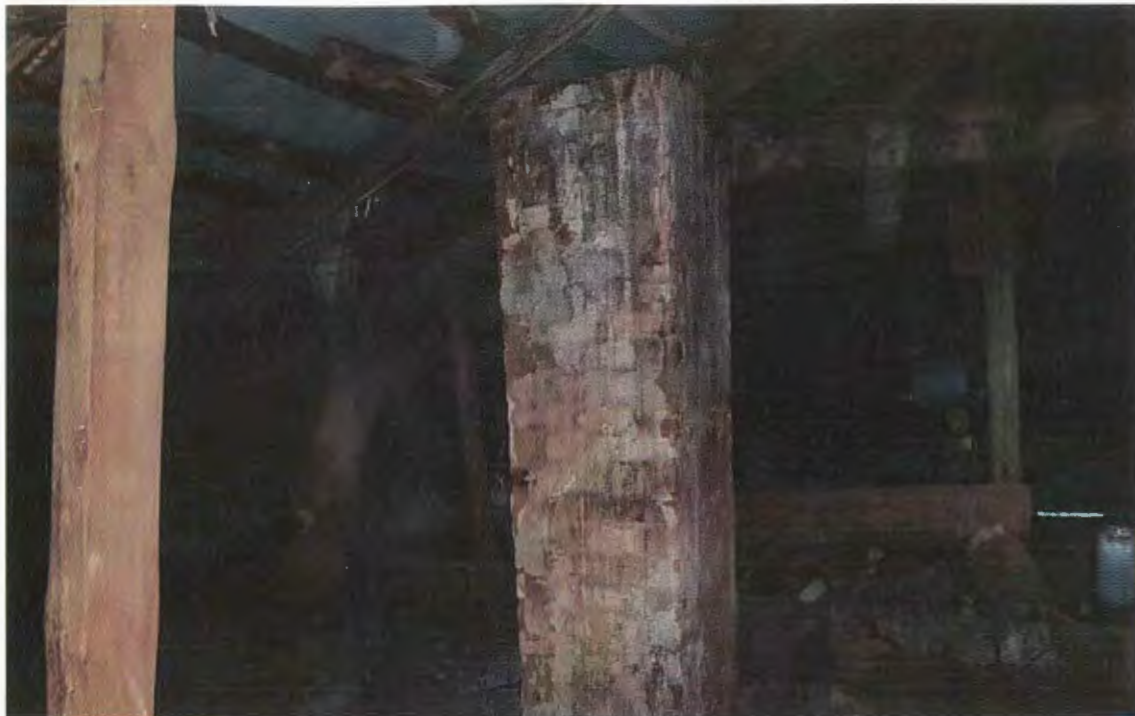
Фото 11. Кирпичный дымоход не выходит на кровлю. Дымоход недействующий.
