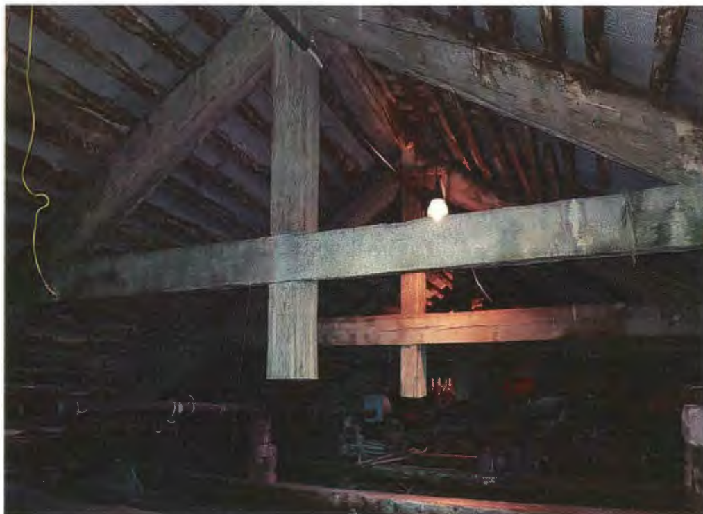
Фото 10. Общий вид чердака здания
