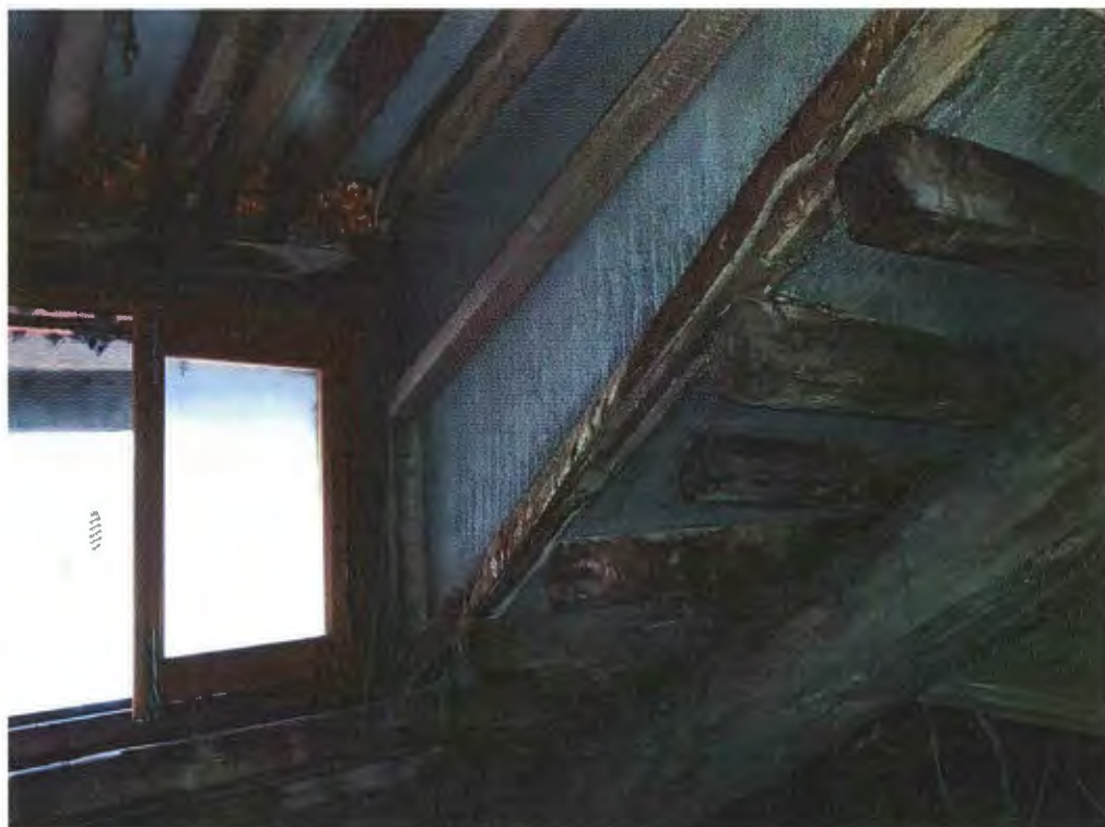
Фото 10. Слуховое окно крыши
