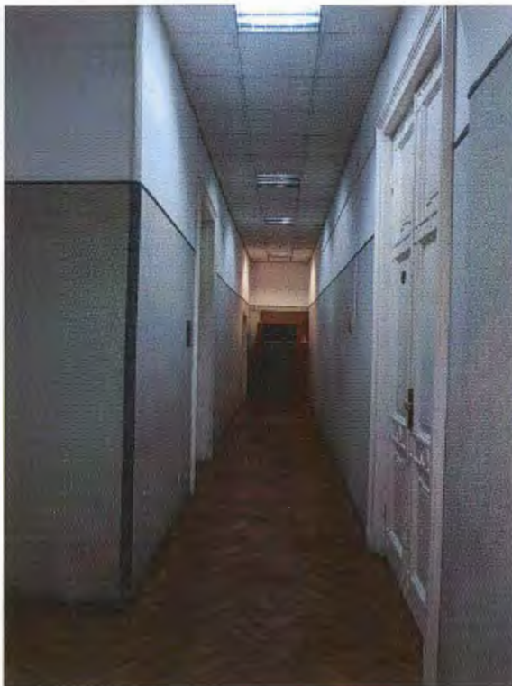
Фото 5. Общий помещений 2 этажа в осях «5-8/Г-Е»
