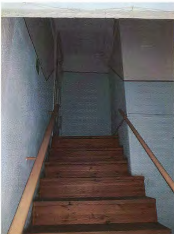
Фото 6. Деревянная лестница подъема на антресоль в осях «9-10/Г»
