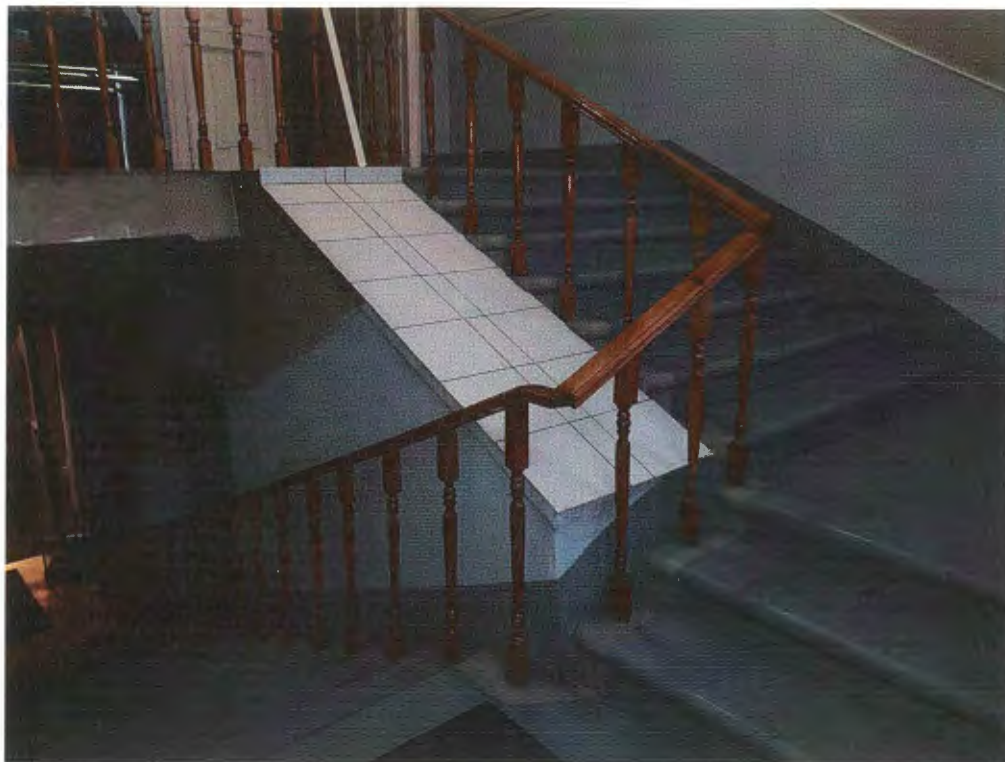
Фото 3. Общий вид лестницы в осях «3-4/Д-Ж»
